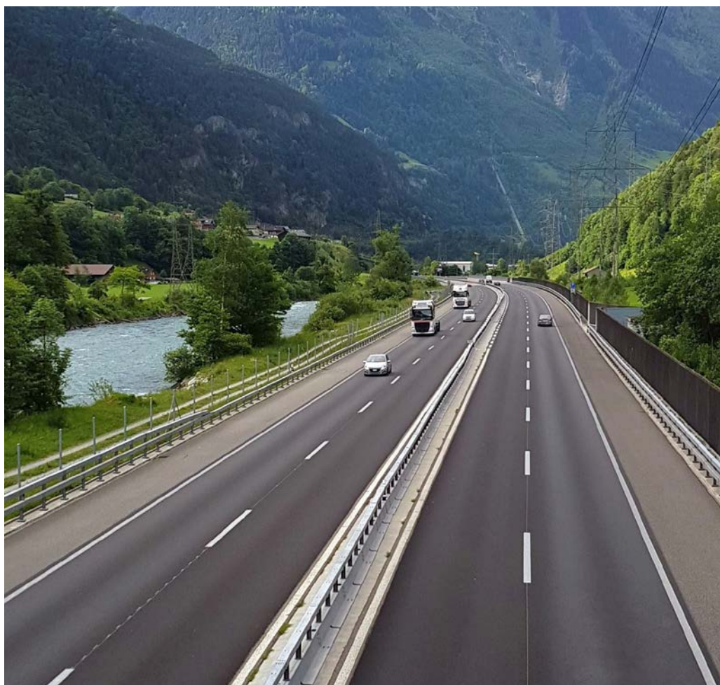
Die Autobahn A2 im Kanton Uri im Frühling 2020 während des Lockdown. (Bild Hannah Wey, inNET Monitoring AG)
